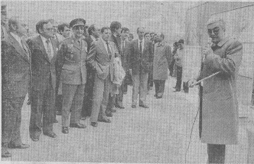
El subsecretario de Obras Públicas y autoridades burgalesas, con consejeros de «Eurovias», siguen las explicaciones ofrecidas relacionadas con las obras realizadas en el desfiladero de Pancorbo y que han permitido la conclusión del tramo de autopista, que ayer entró en servicio. — (Foto FEDE)
