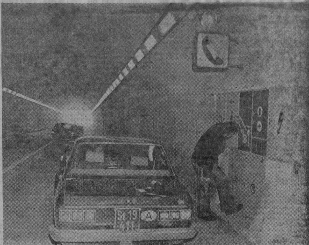
Todo conductor con problemas en el túnel del «Wolfsberg», de 750 metros de longitud, puede contar con el más rápido auxilio. La «Siemens» austriaca ha instalado un modernísimo sistema de seguridad en el tramo ya abierto al tráfico de la autopista que enlazará Salzburgo con Carintia. Cada 212 metros se han montado puestos de llamada de emergencia, así como extintores y botiquín. Basta apretar un botón para llamar al médico, a la Policía de tráfico, al mecánico o a los bomberos. — (Foto FIEL).
