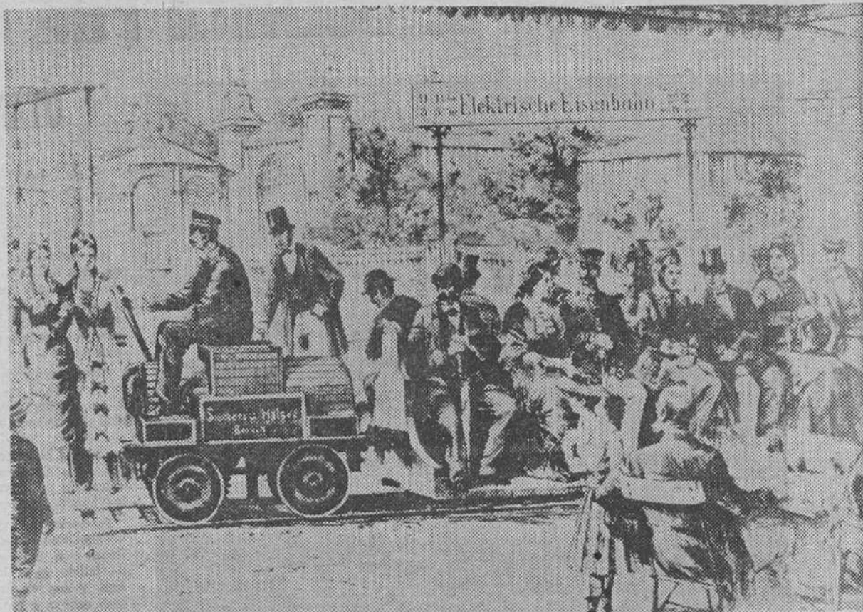
Munich (DID). — Así comenzó hace una centuria la era del transporte eléctrico: en el recinto de la exposición de la artesanía, en Berlín, funcionó por vez primera en Mayo de 1879 un vehículo sobre vías accionado por corriente y motor eléctrico. Werner von Siemens, el gran pionero de la electrónica y fundador del actual consorcio mundial, construyó este primer vehículo eléctrico. Dotado de un motor de 2,2 kilovatios (tres caballos, según la antigua denominación) para 150 voltios de corriente continua arrastró tres pequeños vagones con seis asientos cada uno sobre un trayecto de 300 metros. La feliz primicia del 31 de Mayo de aquel año fue seguida de otros cinco mil viajes durante la duración de la exposición. — (Foto (DID)).
