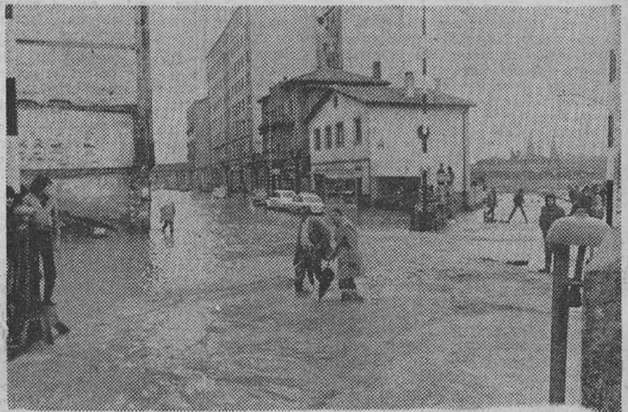
Así estaba el paso a nivel de San Pedro y San Felices. — (Foto FEDE)
