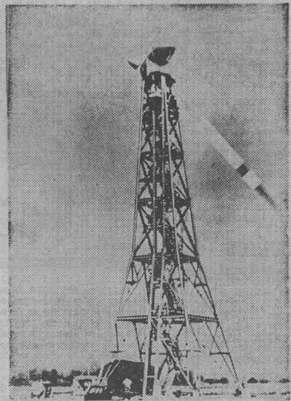
Molino de viento para generar electricidad eólica. Sus aspas miden 80 metros de diámetro. Ha sido instalado en Sandusky (Ohio). — (Foto Efe-Fiel).
