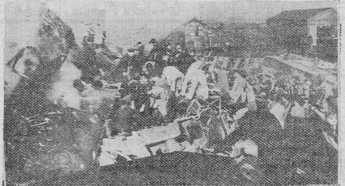
CATÁSTROFE FERROVIARIA Harrow (Inglaterra). — Vista de la estación de Harrow y Wealdstone, donde chocaron tres trenes, resultando más de un centenar de muertos y otros tantos heridos, durante los primeros trabajos de salvamento de las víctimas. — (Foto Cifra).
