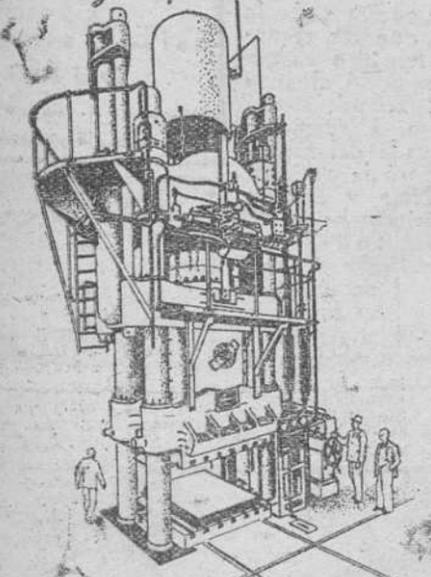
para la fabricación de resina artificial, de una presión total de 5.000.000 de kilos, fué construída por la casa BECKER & van HÜLLEN, de Krefeld, para satisfacer la necesidad de la fabricación de piezas muy grandes de resina artificial.
