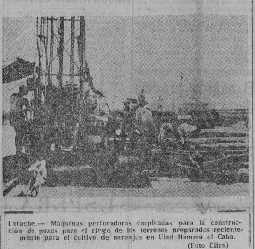
Larache. — Máquinas perforadoras empleadas para la construcción de pozos para el riego de los terrenos preparados recientemente para el cultivo de naranjos en Ulad Hammú el Caba. (Foto Cifra)
