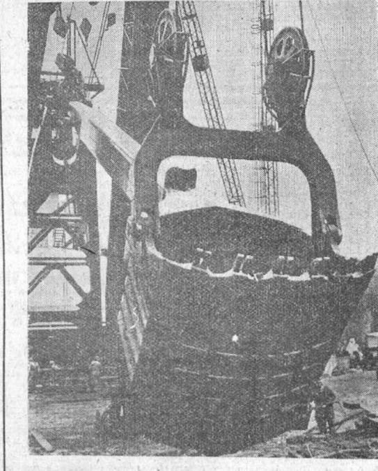
Cádiz (Ohio, EE. UU.).—La mayor excavadora del mundo acaba de entrar en funcionamiento en esta localidad. Su capacidad es el que puede coger 90 toneladas de tierra de una sola vez, y para su control y movimiento la General Electric ha tenido que construir un motor especial de 40.000 H. P. de fuerza.—(Foto ICE)
