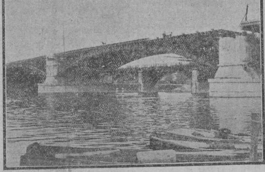
El viejo puente d'Argenteuil, averiado durante la guerra, va a ser reconstruido. Los seis arcos, excesivamente estrechos, que dificultaban la navegación fluvial, están siendo reemplazados por tres metálicos y el piso del puente sufrirá una considerable elevación, en forma que permita el paso de los remolcadores. El nuevo puente, cuyo monumento fue inaugurado hace poco, será abierto a la circulación en el próximo mes de Julio.
