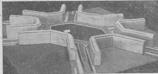
Para la reconstrucción de uno de los centros de tráfico más congestionados de Londres, el "Elephant and Castle" se ha escogido el proyecto que nos muestra esta maqueta y que prevé la construcción de un paso elevado sobre el nivel del suelo, otro por debajo del anterior y una estación subterránea para autobuses y tranvías. (Foto Calpe).
