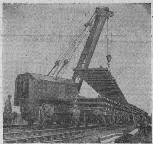
En las líneas de ferrocarriles ingresa se esta aplicando el sistema de tomas de agua durante la marcha del tren. Para adelantar el trabajo se utiliza la prefabricación de los elementos de los depósitos, de la parte inferior de la vía y de las secciones especiales de ésta. Todo este trabajo se realiza en los talleres y se instala definitivamente manejándolo con grúas móviles como vemos en la fotografía. (Calpe).
