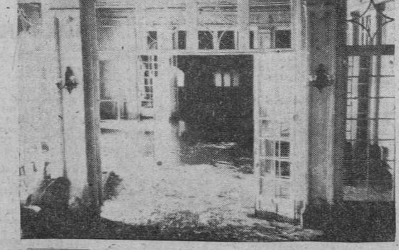
Málaga.—Desolador aspecto que ofrecía la sala principal baja del sanatorio "18 de Julio", a consecuencia de las inundaciones. — (Foto Cifra)
