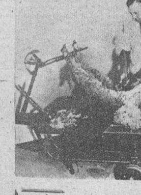
En Inglaterra se está ensayando este aparato semiautomático para esquilarse el ganado lanar. La oveja queda sujeta por las cuatro patas a una plataforma que puede girar de modo que el operario no necesita moverse.
