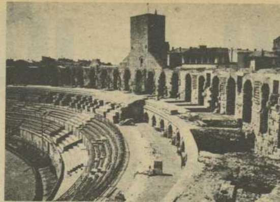
HABILITACION. —Para su habilitación como plaza de toros hubo que hacer en Arlés numerosas obras en sucesivas etapas. La foto nos muestra un aspecto de la transformación, realizada hace bastantes años
