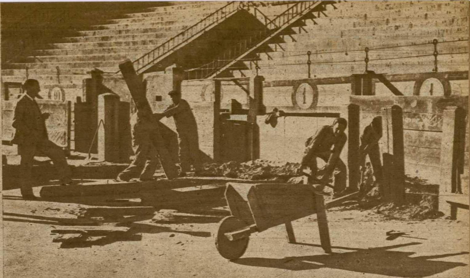
He ahí a los obreros trabajando en el derribo de la Plaza de Toros vieja, de Madrid, derribo que empezó por el tendido 1
