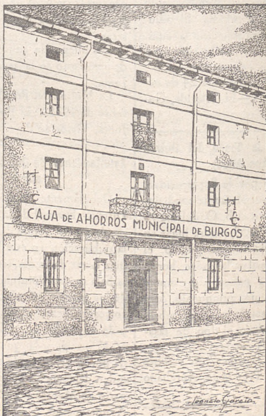
Oficina donde está instalada la Caja de Ahorro Municipal, en Monasterio de Rodilla
