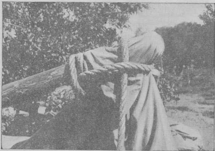
Fig. 23.—Sujeción de la tela al pie derecho.
