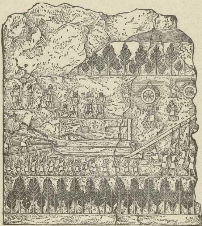
REPRESENTA EL ACTO DE REMOLCAR LA MITAD DE UN TORO ALADO EN UN CARRETÓN SIN RUEDAS SOBRE RODILLOS ENGRASADOS.
