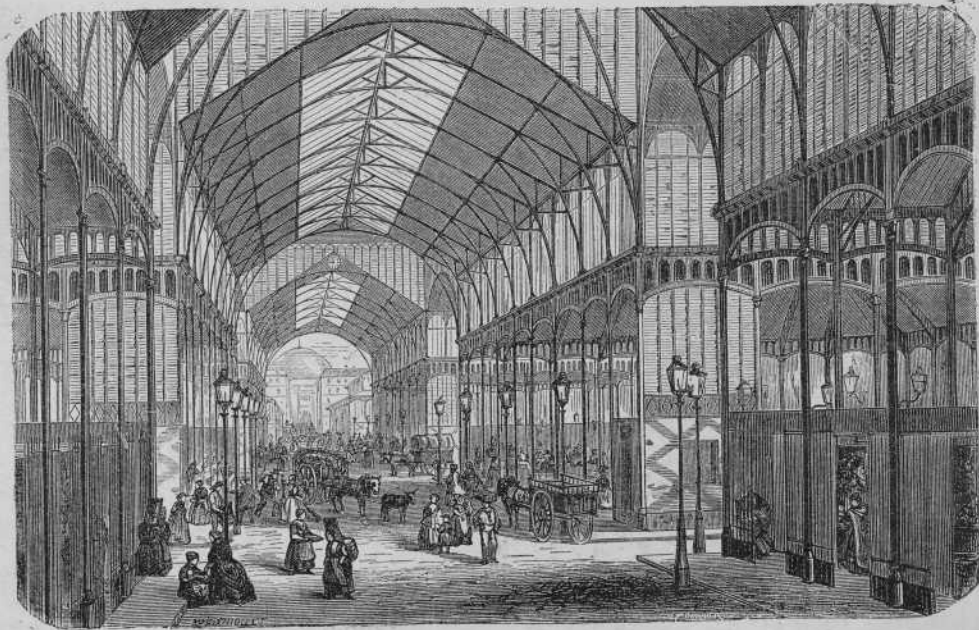
Intérieur des Halles centrales.
