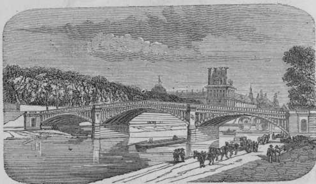
Pont de Solférino.
