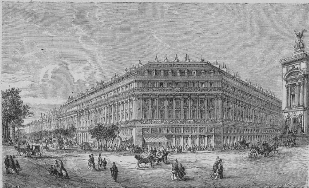
Façade du Grand-Hôtel.
