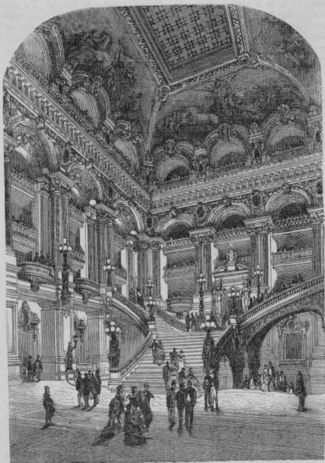
Grand escalier d'honneur du nouvel Opéra.
