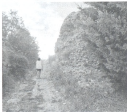
Restos de la cerca (muralla) situados al pie de la subida del castillo.
