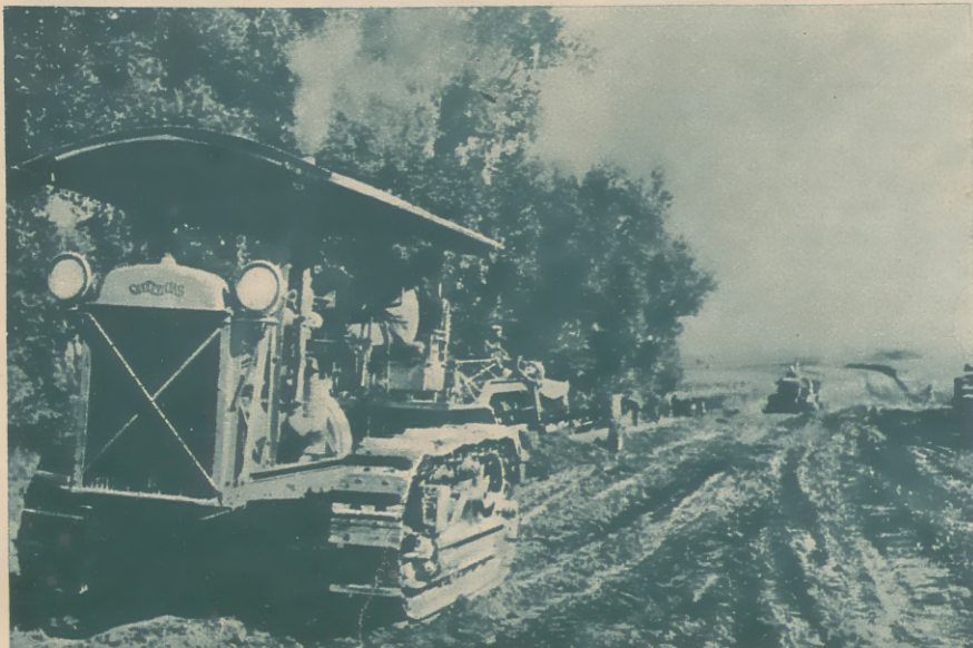
Tractores construyendo las carreteras que juntan Shinkin con el resto del país
