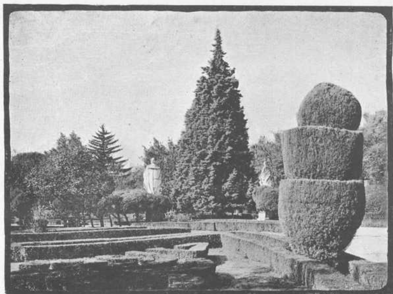
f.190.-Una vista del parterre
