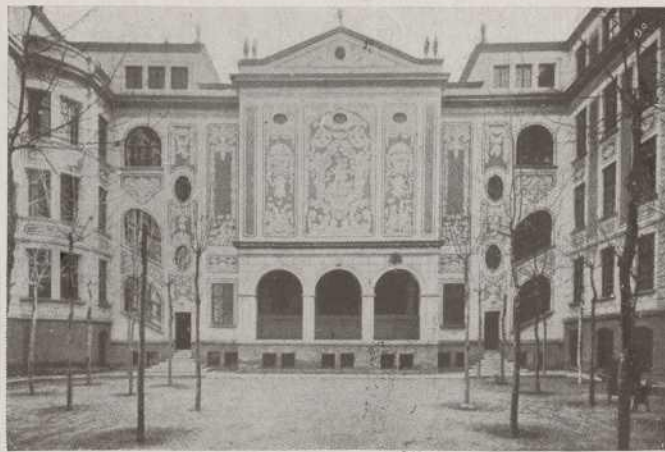
Grup Escolar Milà i Fontanals i Lluïsa Cura. — Façana interior i pati de joc.
