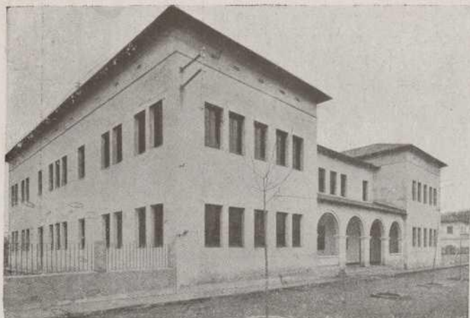
Grup Escolar Bonaventura Carles Aribau. — Vista general.
