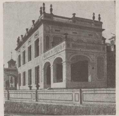
Grup Escolar "La Farigola". — Un aspecte del conjunt de l'edifici.
