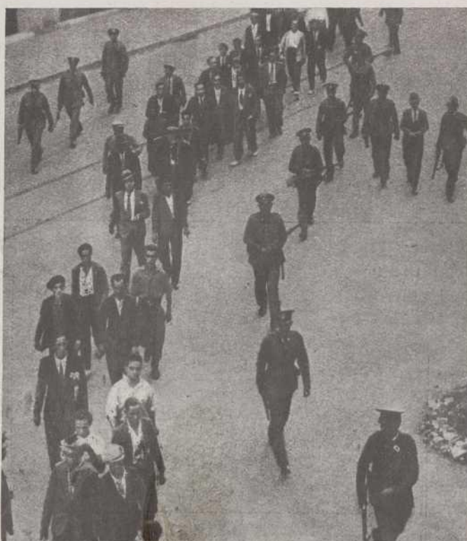
Els vaguistes que varen plantar cara a la policia des del Sindicat de Construcció en ésser conduïts a la delegació.
