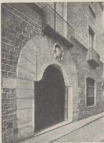
Portalada d'entrada a l'Institut
