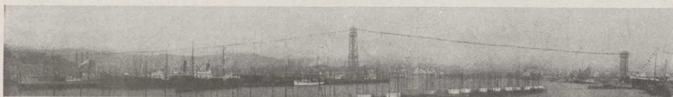
Vista general de tota l'instal·lació aèria
