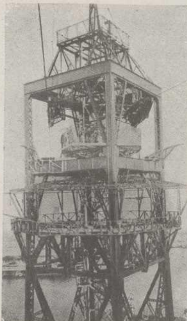
Capdamunt de la torre central del ferrocarril aeri.
