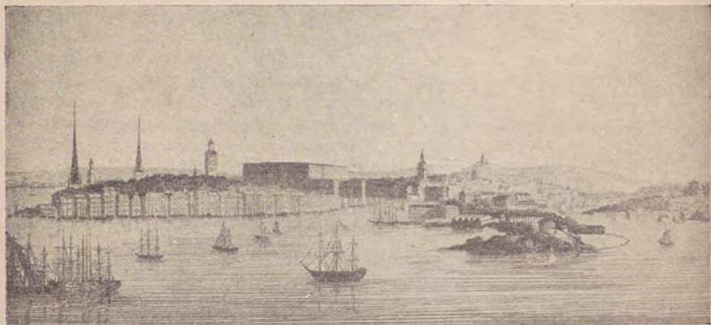
Stockolmo (Suecia) (estado actual).
