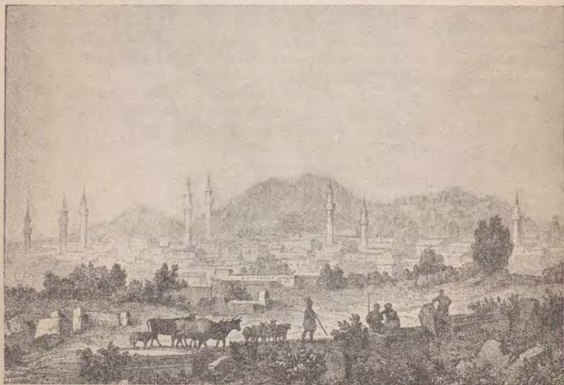
Vista de Angora en su estado actual.
