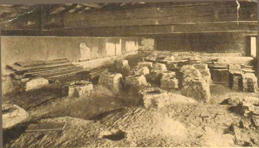
50. TORDESILLAS.—Monasterio de Santa Clara. Trasdoses de las bóvedas y respiraderos de los Baños Arabes.
