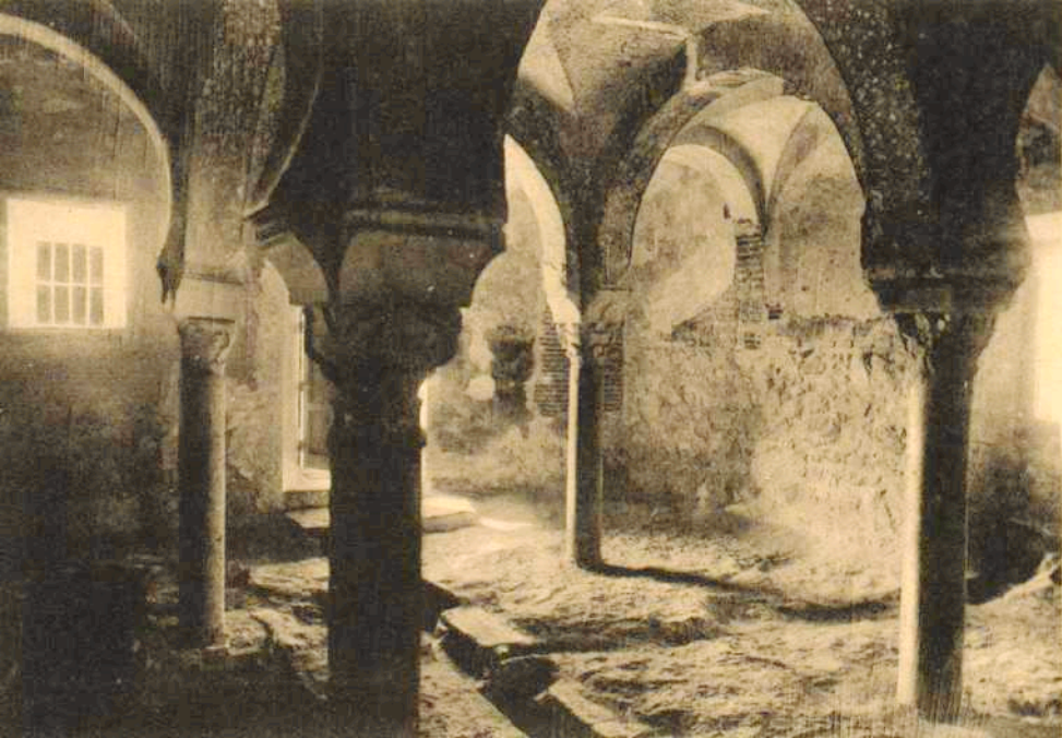
44. TORDESILLAS.—Monasterio de Santa Clara. Otro aspecto de la «Sala grande» de los Baños Arabes.
