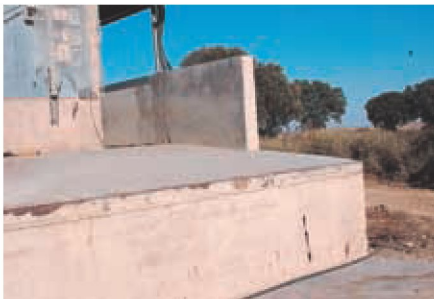
Muelle de carga y descarga de animales que se debe localizar al lado del vallado para evitar que los camiones entren en la explotación.
