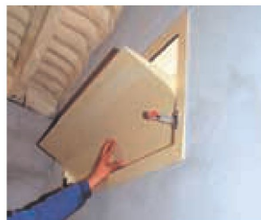
Entrada de aire por deflector.
