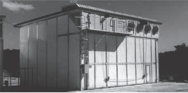
Figura 16. Secadero con bomba de calor.
