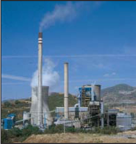
Central térmica de La Robla.
