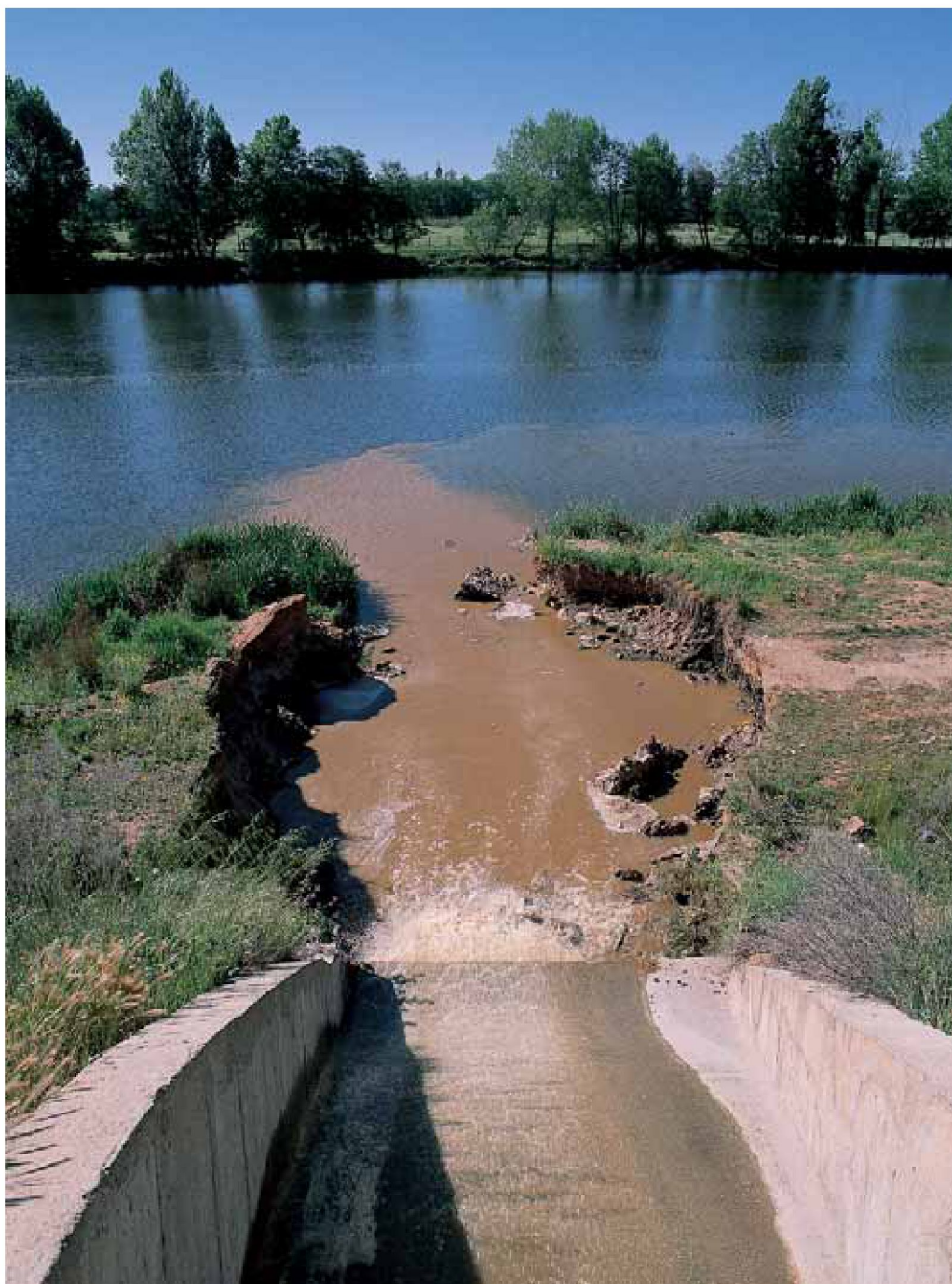
Vertido desde el colector del polígono industrial "Tormes" en Salamanca.
