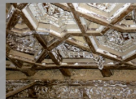
Detalle armadura de cubierta
