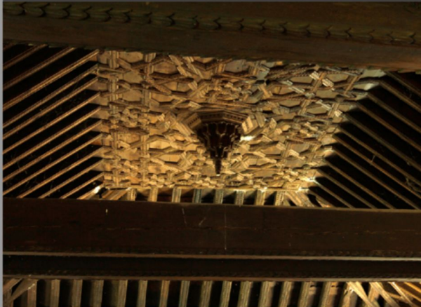
Detalle de la armadura de cubierta de la nave
