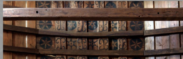
Armadura de cubierta de la nave
