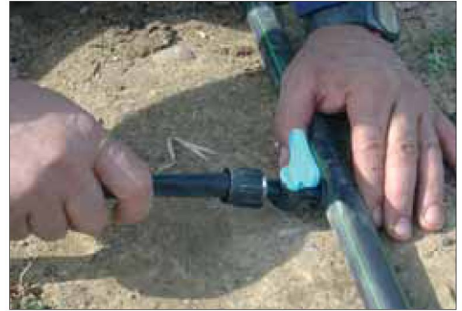
14.4: incisión en la tubería general para instalar el lateral de riego por goteo (cinta de riego)
