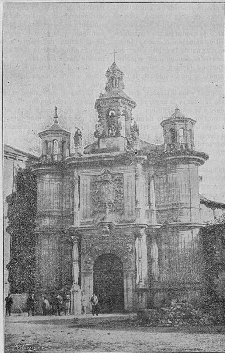
FACHADA DE LA IGLESIA DE SAN JUAN DE LETRÁN
