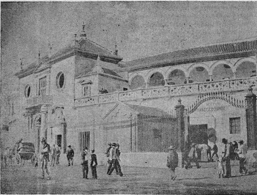
Plaza de toros de Sevilla.—Vista exterior.
