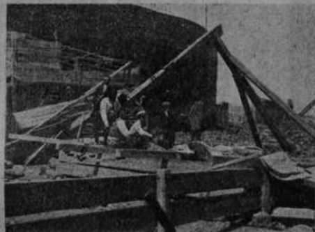
Lugar donde estaba la enfermería, de la que no han quedado ni los muros, habiéndose perdido las camas y todo el material de curas que ha quedado sepultado entre las arenas del mar que se ve al fondo de las dos fotografías
