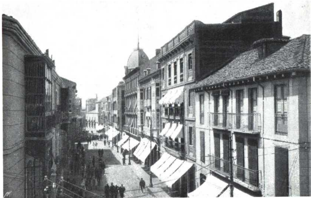
Figura entre las principales vías de la capital, ocupada por numerosos establecimientos mercantiles.
