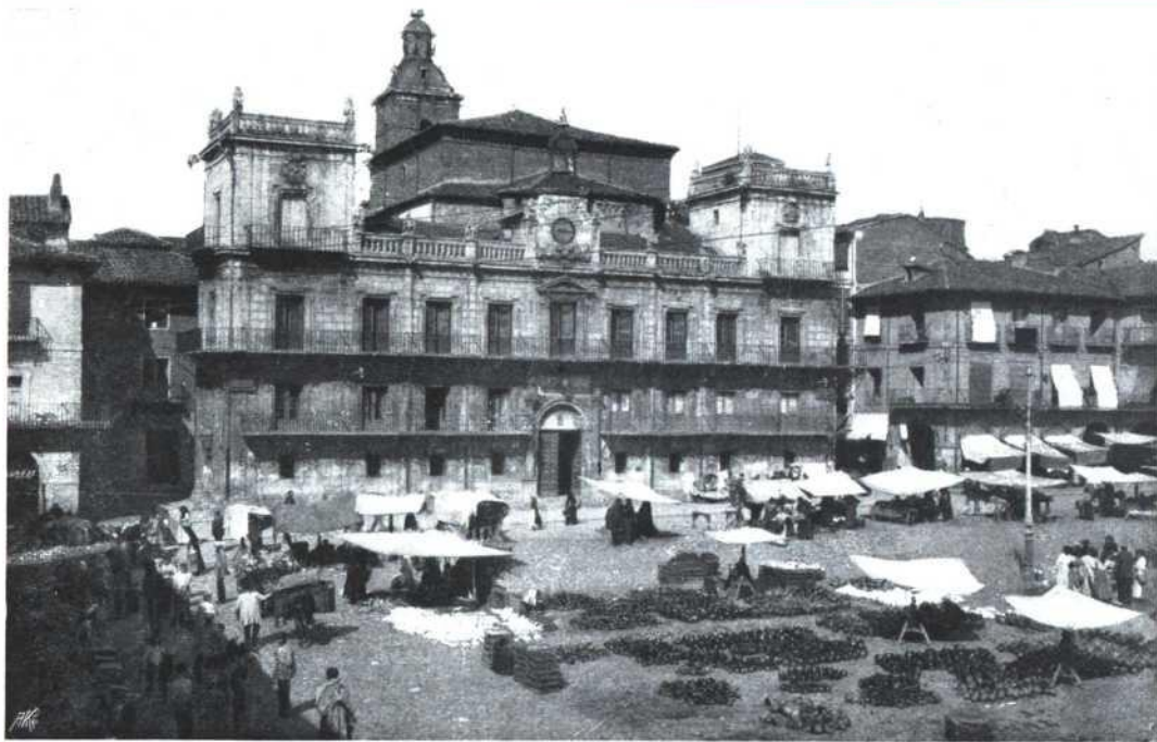
Ocupa uno de los lados de la plaza Mayor, habiéndose terminado su construcción en el año 1677.
