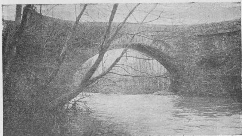
PUENTE DE TORRE SOBRE EL RÍO TREMOR
