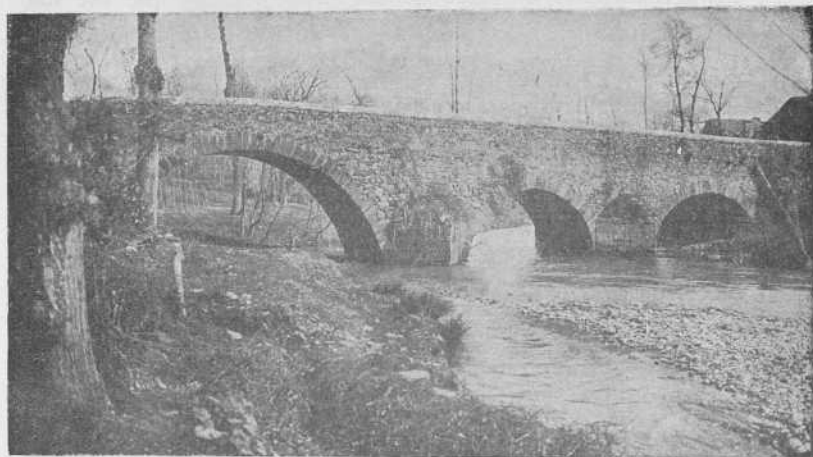
PUENTE DE SAN ROMÁN SOBRE EL RÍO NOCEDA
