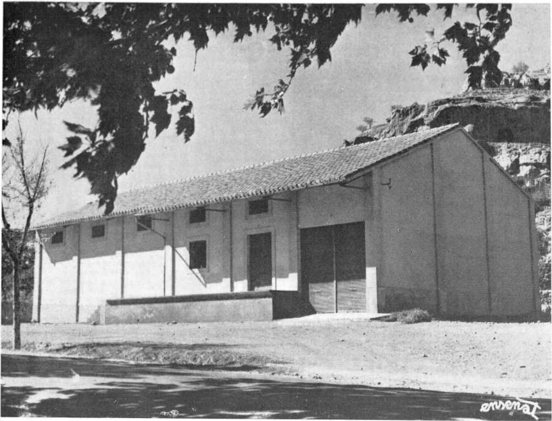
Foto núm. 8.—Exterior del Almacén de Arnedo.
