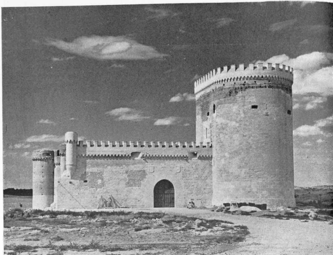
Foto núm. 73.—Castillo de Arévalo. Restauración exterior.
