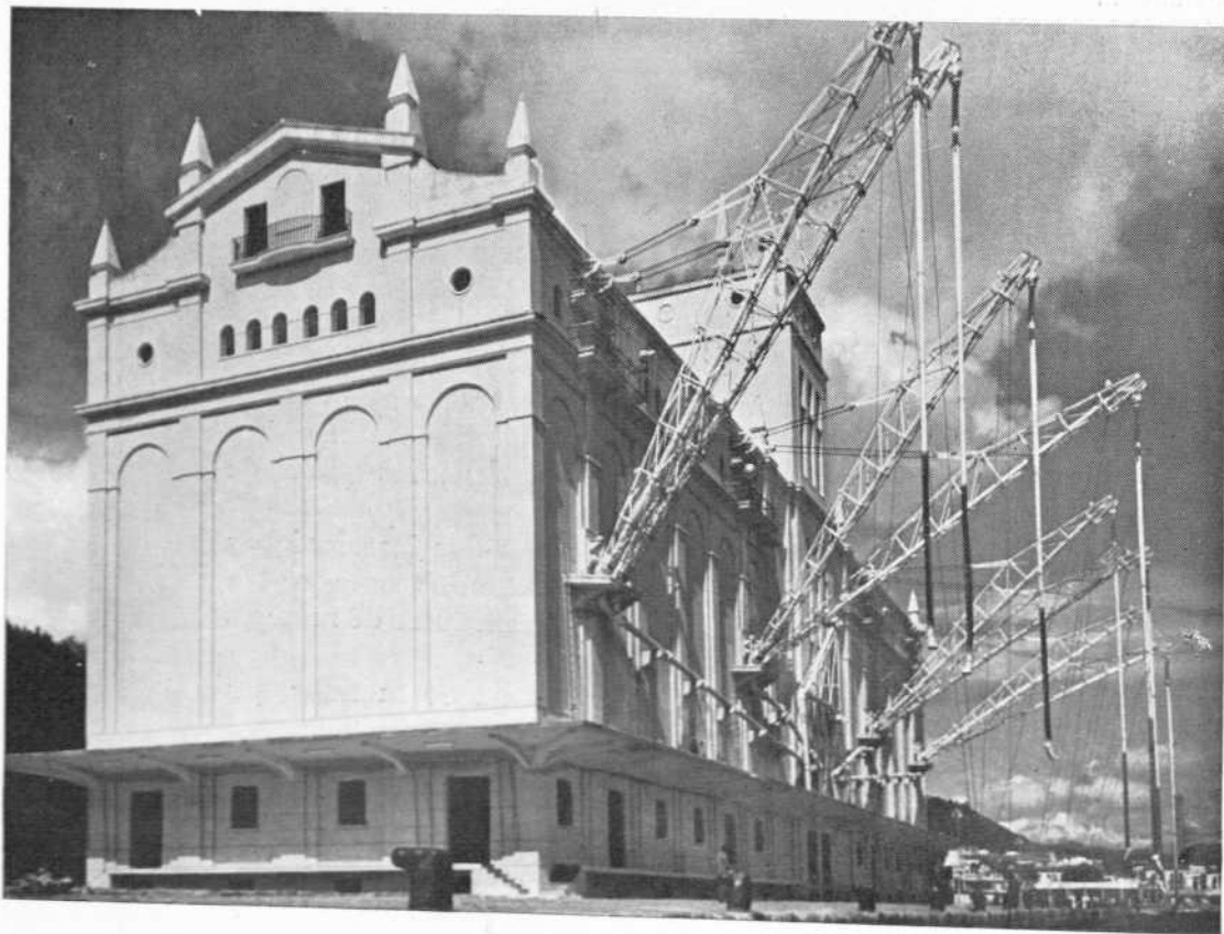
Foto núm. 55.—Silo de Málaga. Detalle de la instalación neumática de carga y descarga de buques.
