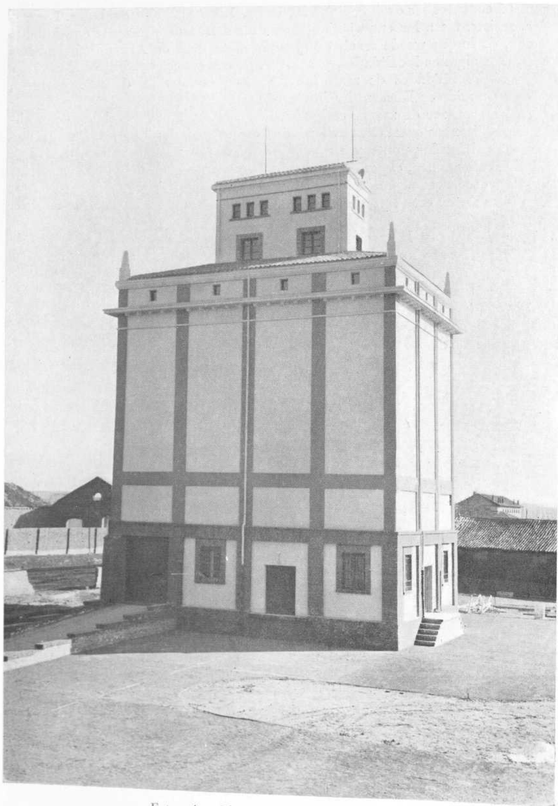
Foto núm. 16.—Silo de Villada (Palencia).
