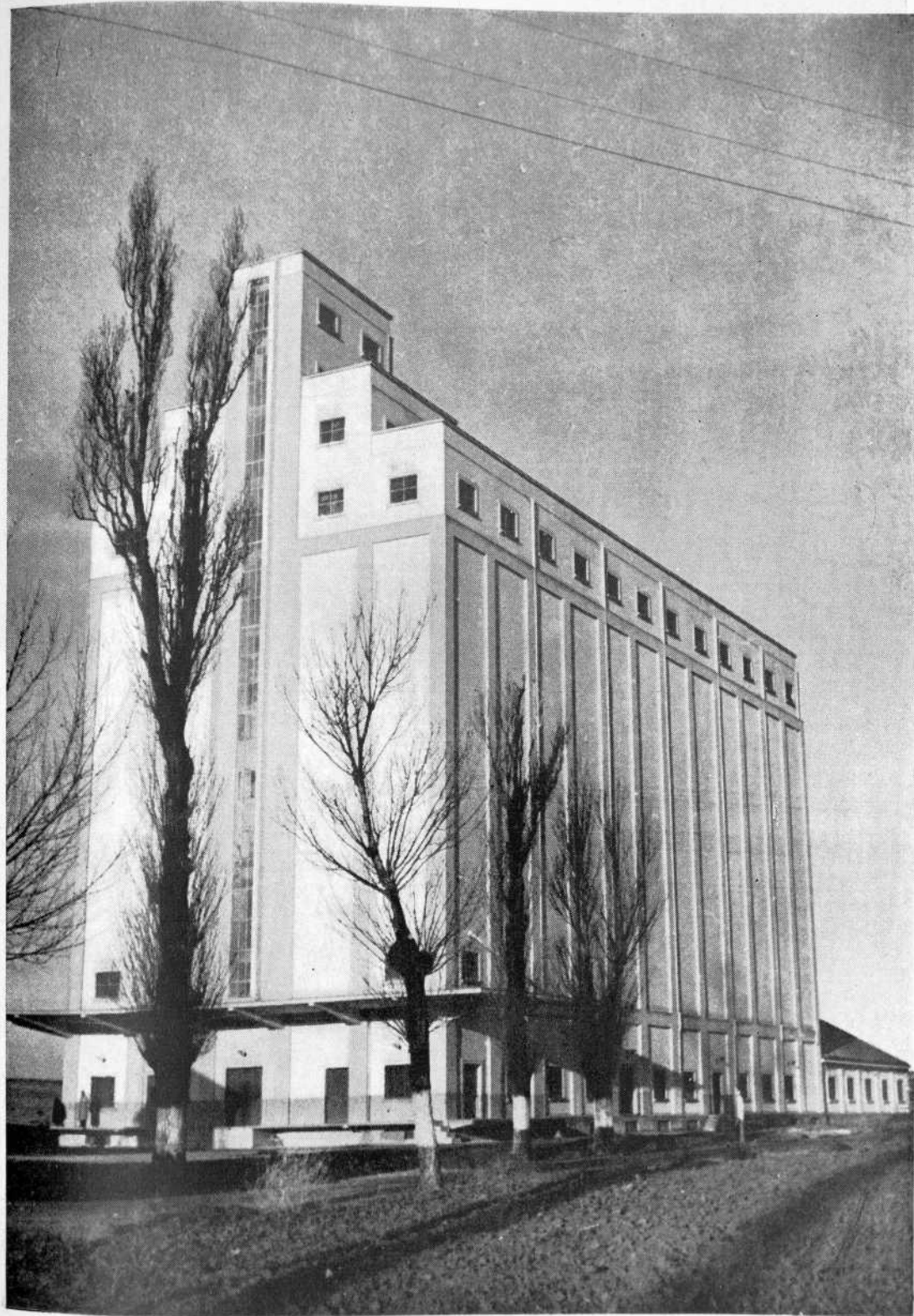
Foto núm. 70.—Silo de Medina de Rioseco (Valladolid).
