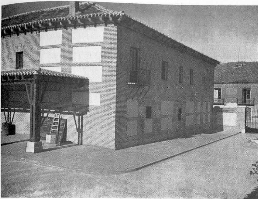
Foto núm. 86.—Casa señorial de Rueda (Valladolid). Aspecto parcial de la restauración.
