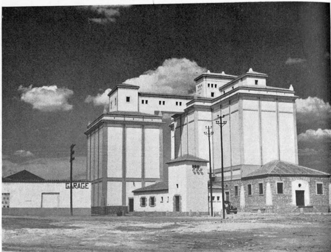
Foto núm. 71.—Silo de Trujillo (Cáceres).
