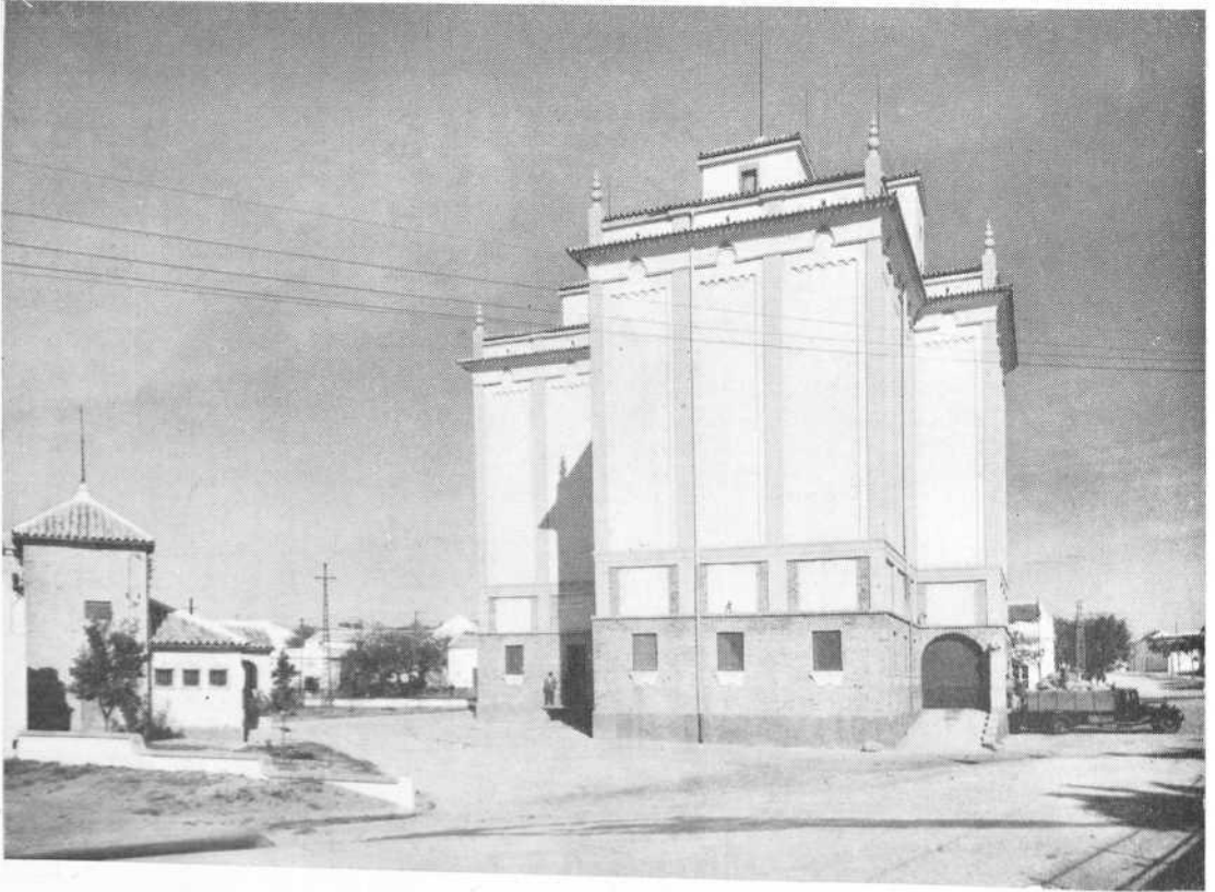
Foto núm. 25.—Silo de Carmona (Sevilla).
