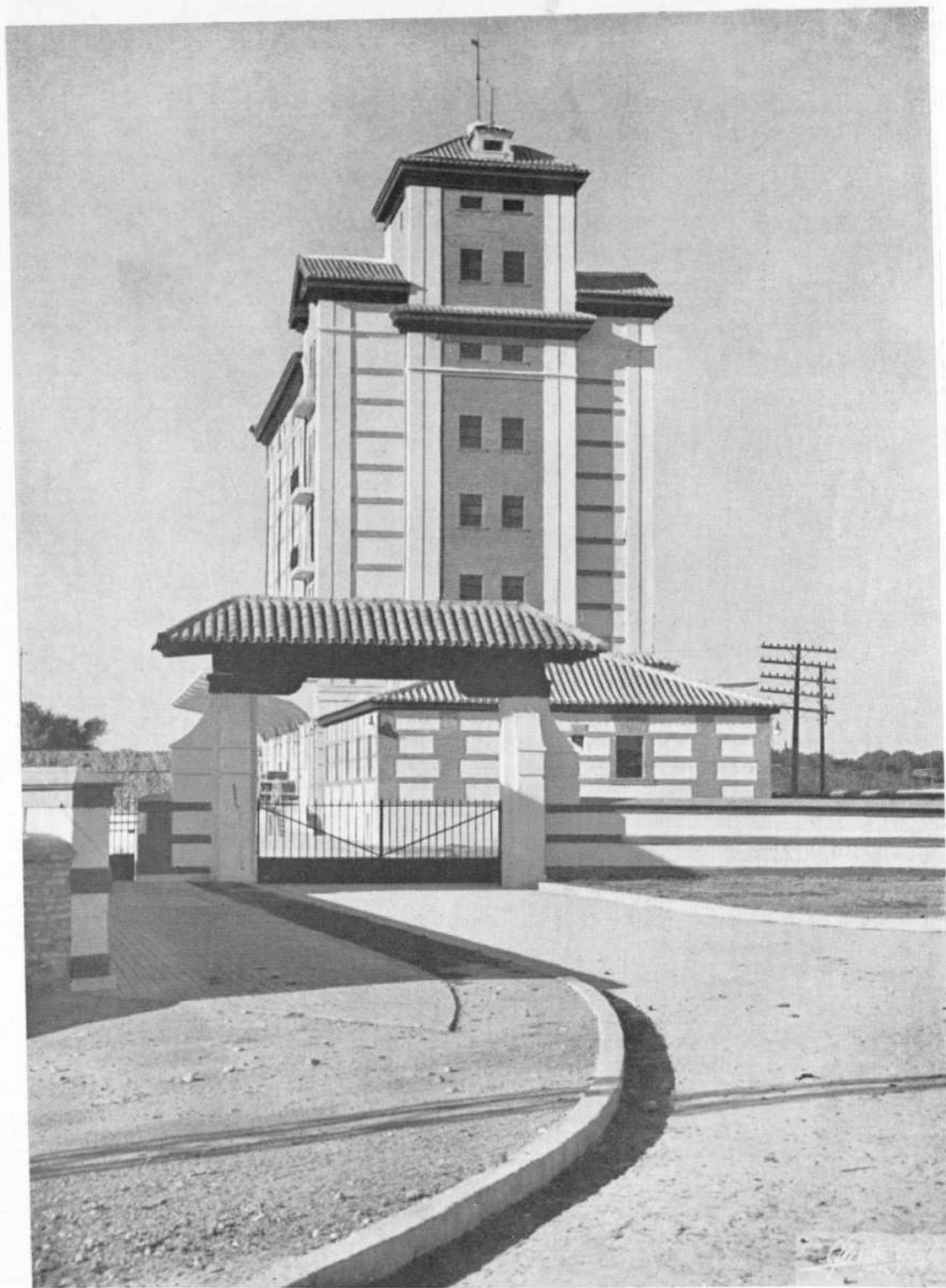
Foto núm. 38.—Silo de Alcalá de Henares (Madrid).
