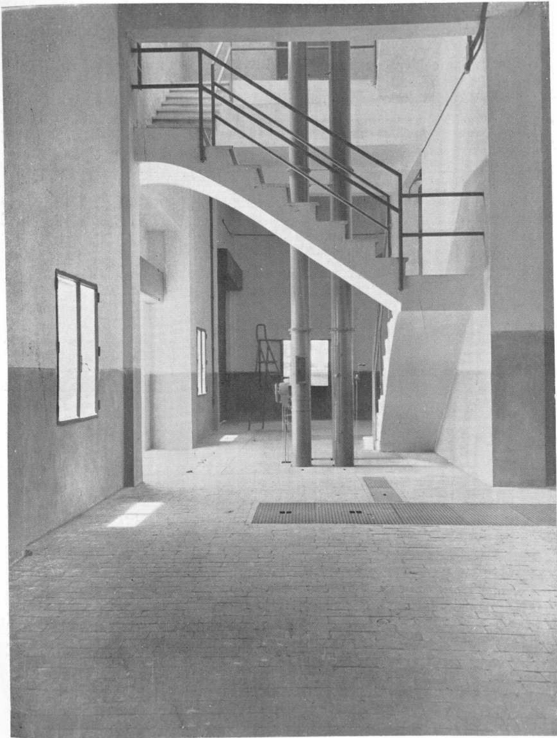
Foto núm. 36-B.—Interior del Silo de Arévalo (Avila).
