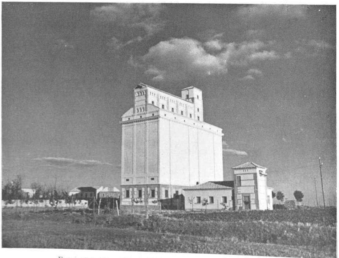
Foto núm. 21.—Silo de Madrigal de las Altas Torres (Avila).
