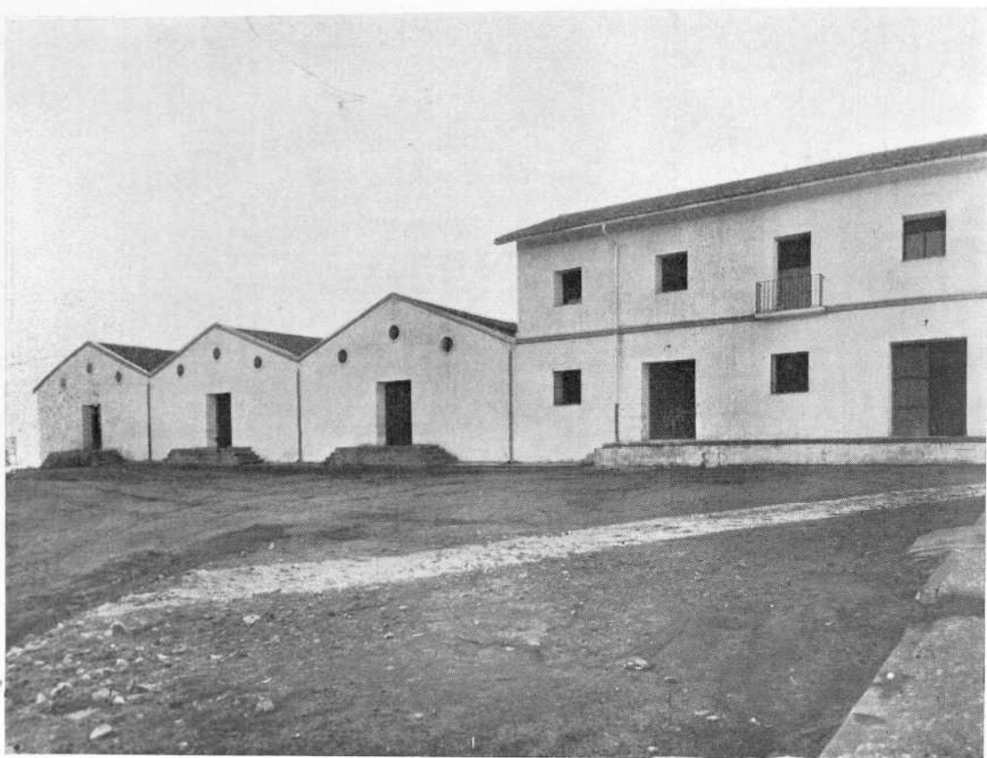
Foto núm. 14.—Exterior del Almacén de Cáceres.
