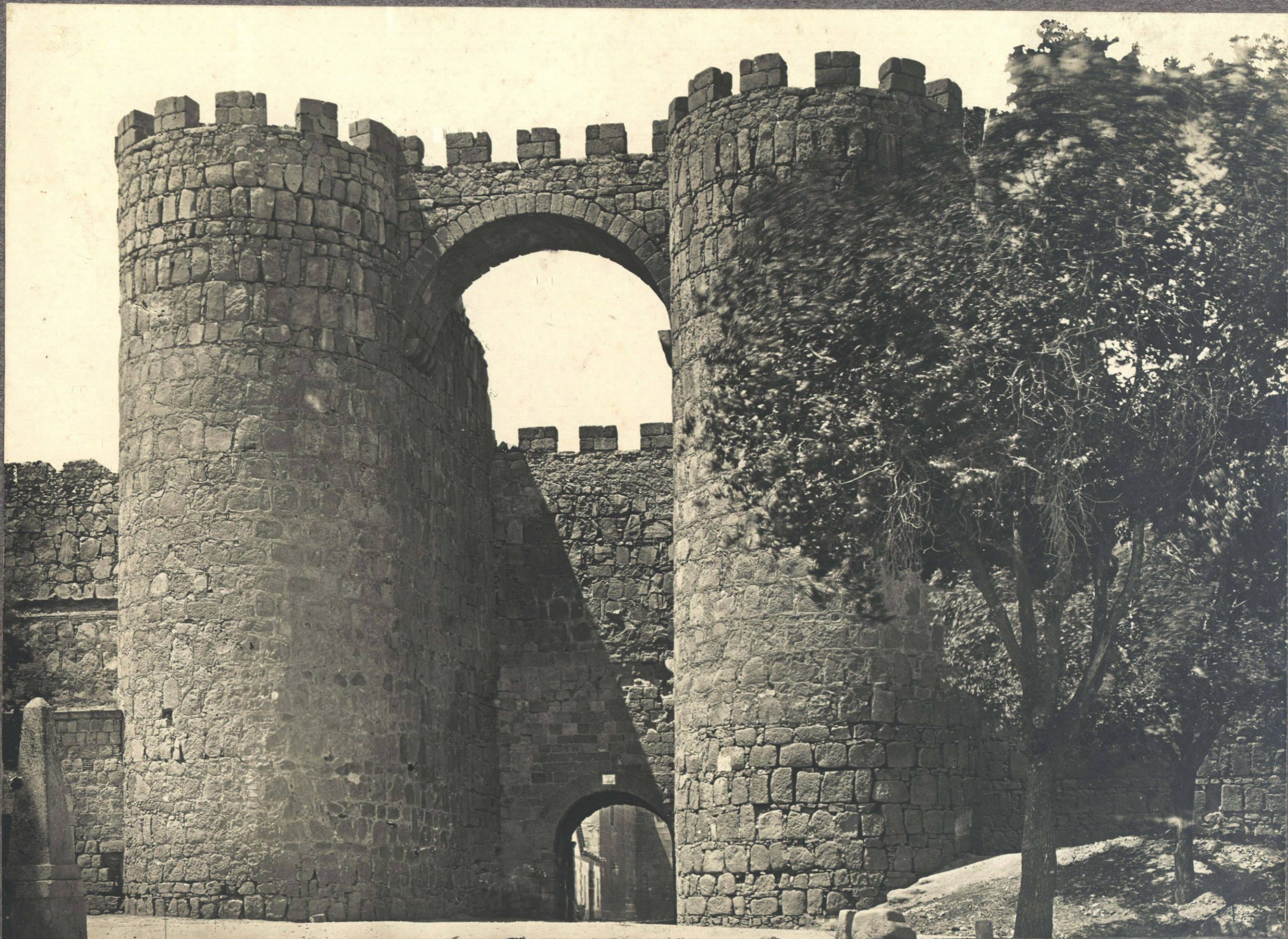
AVILA. — 53. — Puerta de San Vicente. — Entrada de Avila.
