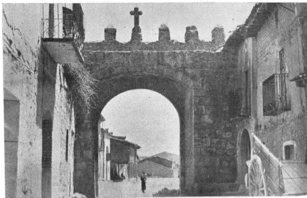
Peñaranda de Duero, una puerta de la antigua muralla.
