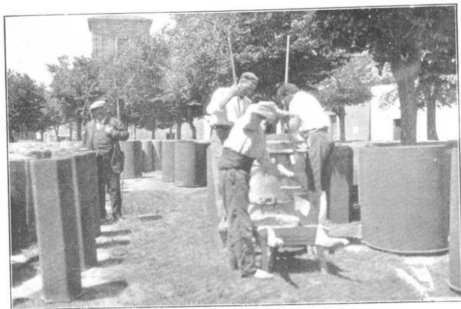
Detalle de la fabricación de tubos para el alcantarillado.
