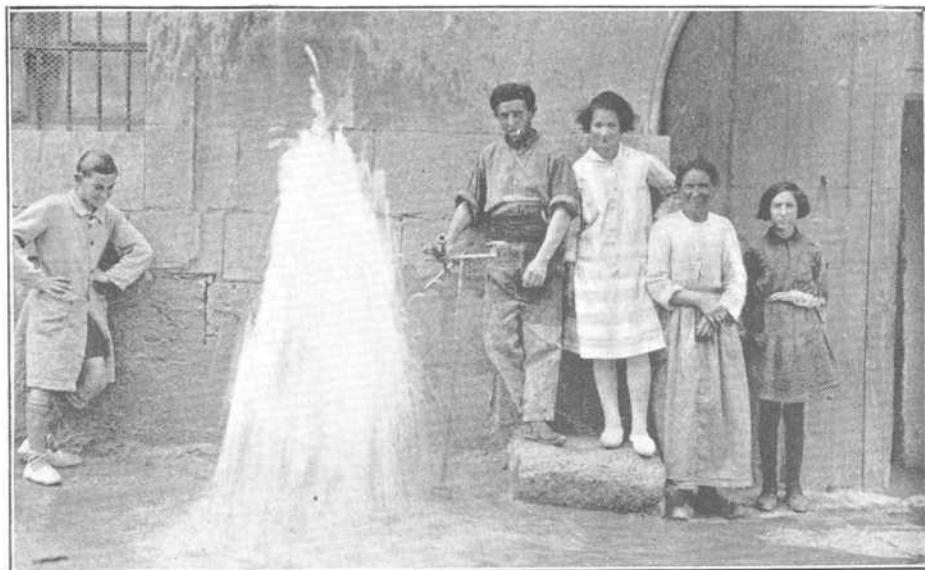
Una de las bocas de incendio, durante las pruebas.
