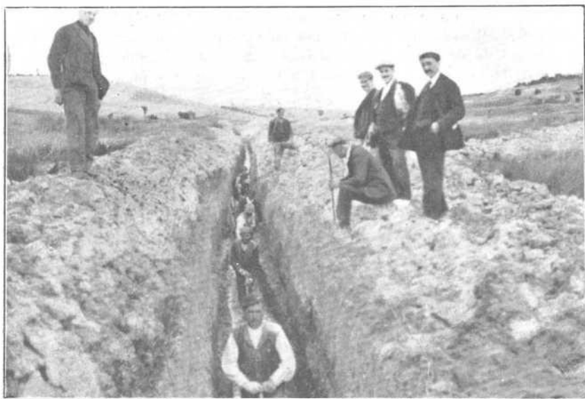
El Alcalde D. Lucinio Merino y algunos concejales, presenciando la apertura de zanjas de exploración.
