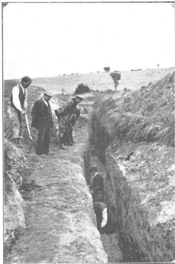
El Delegado Gubernativo D. José Sánchez Romero, con algunos concejales, presenciando uno de los trabajos de ensayo.
