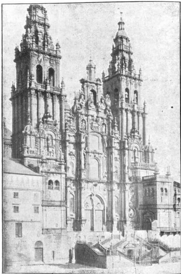
FACHADA DEL OBRADOIRO
