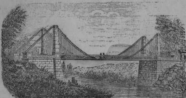
Puente de la Unión en Doña.
