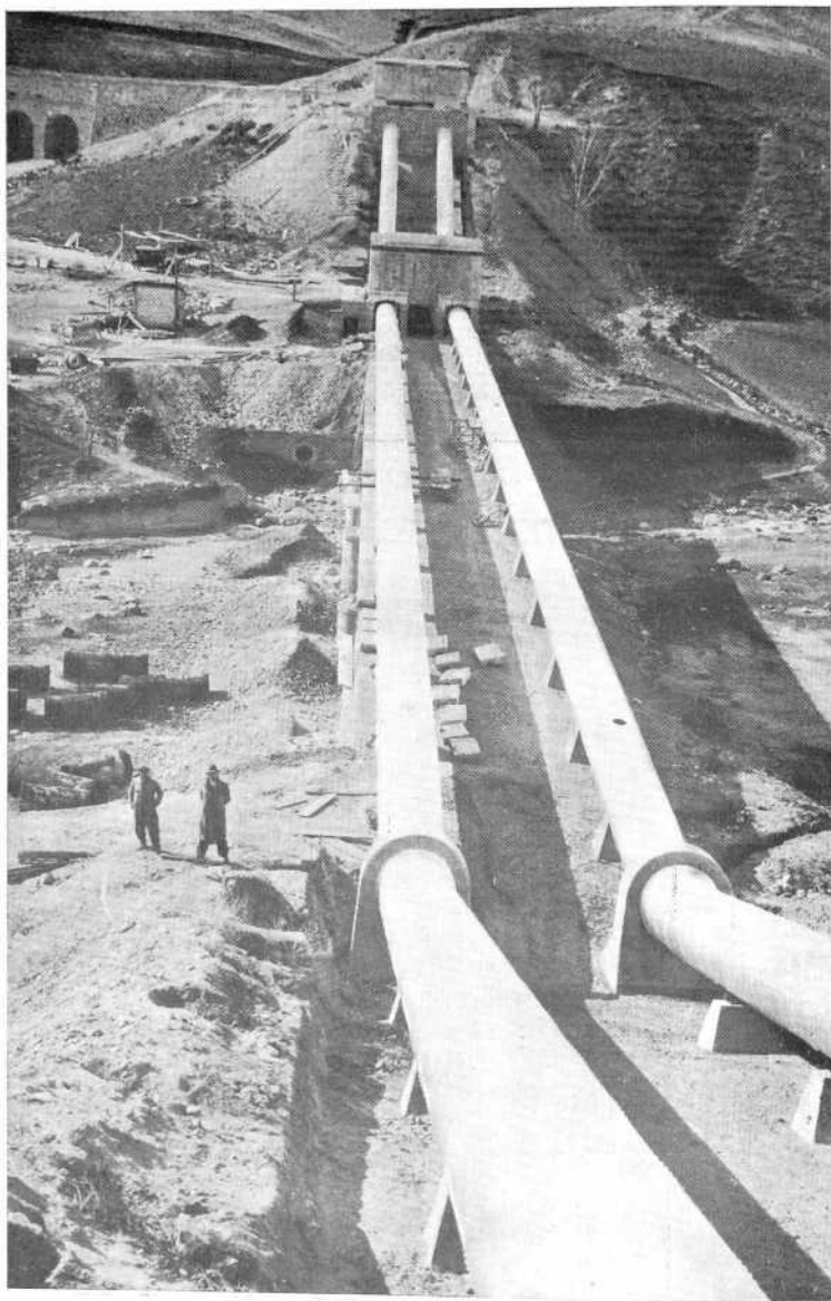
Canales del Lozoya. — Primitivo canal del Lozoya. Sifón del Morenillo.
