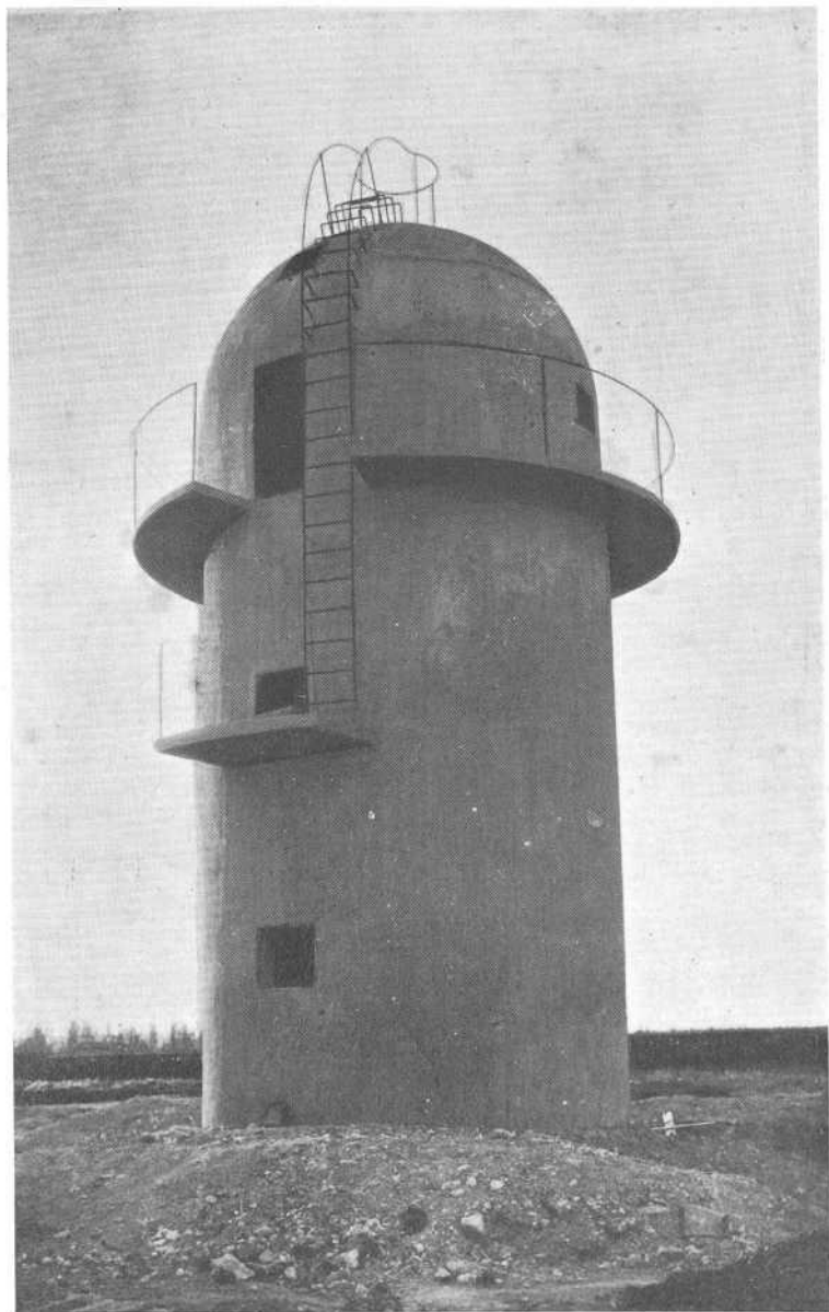
El silo de la Escuela de Palencia.
