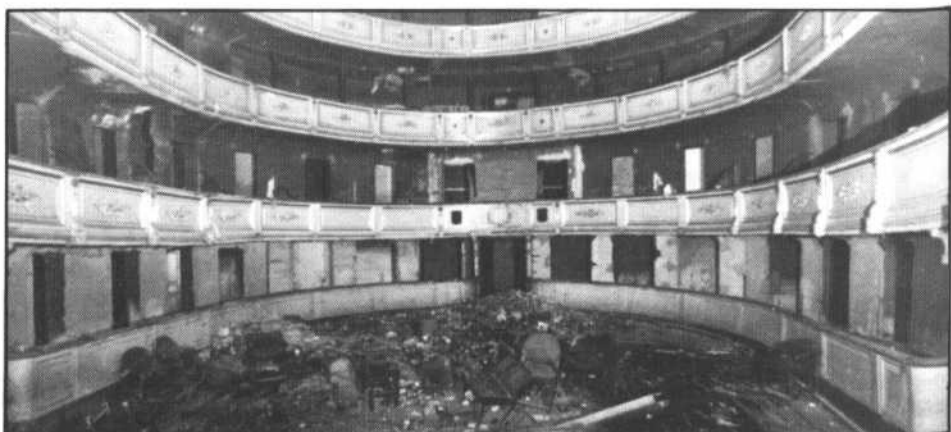
Estado actual del patio de butacas y palcos del Teatro Principal de Burgos.
