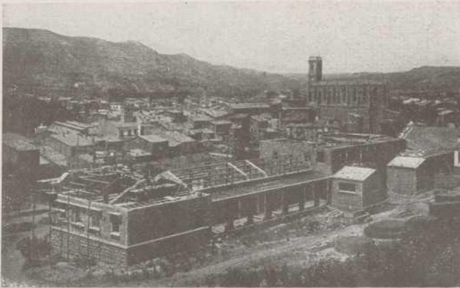
Les escoles en construcció en el llindar del poble
