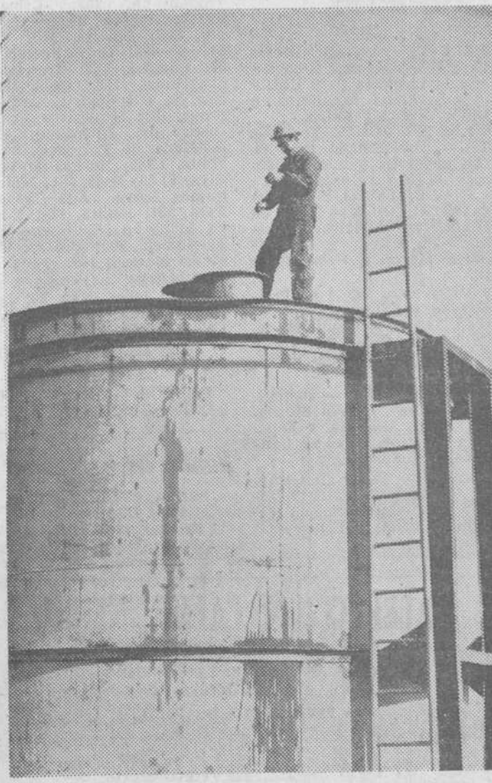
He aquí uno de los dos grandes tanques receptores de petróleo en tierras de Hontomin. — (Foto "Fede")
