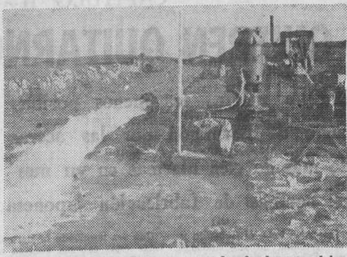
Ciento treinta y seis litros por segundo aforaban, en el instante en que fue obtenida la presente fotografía, en el segundo sondeo realizado en Villaverde Peñahorada. (Foto "Fede")
